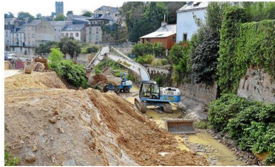
Photo 61 : travaux de consolidation des berges rive gauche de l'Issole (2014)
