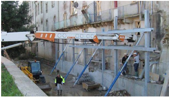
Photo 60 : confortement provisoire des maisons rive droite riveraines de l'Issole (2014)
