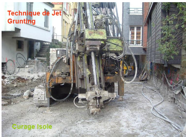
Photo 33: technique de Jet Grouting et Photo 34 : technique du béton projeté sur les fondations
