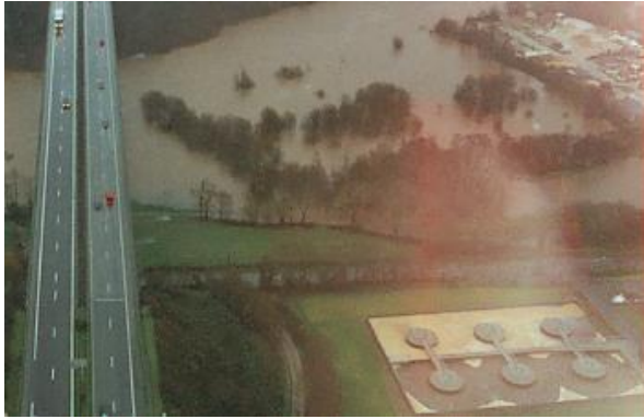
Photo 15 : Station d'épuration de Quimperlé, en bordure de la Laïta (lors de la crue de 2000)
