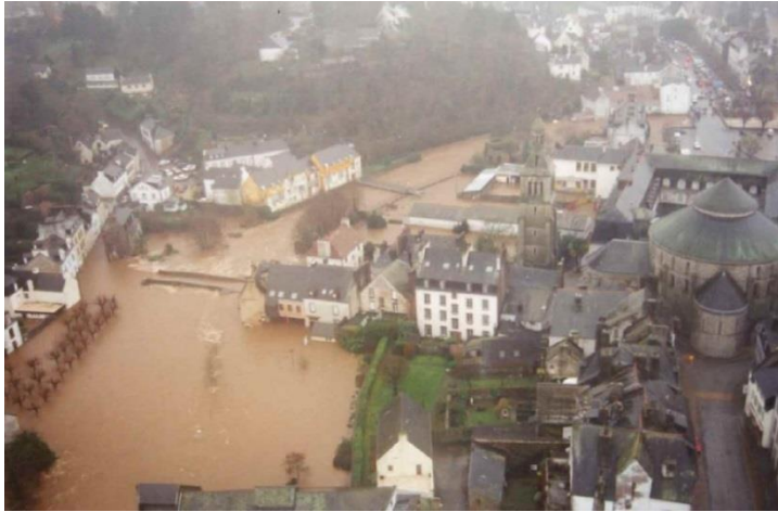
Photo 53 : 06/01/2001, soit le lendemain du pic de crue : le secteur de la Place Lovignon, et du parking en rive droite de l'Ellé ennoyé
