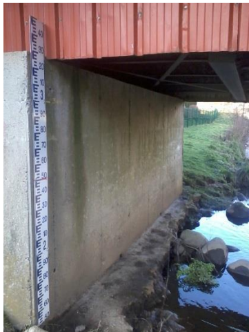
Photo 13 : L'échelle limnimétrique de PENY au droit de leur site (PENY, 03/02/2014)
