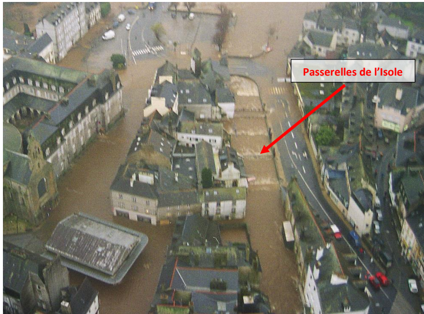
Photo 50 : 06/01/2001, soit le lendemain du pic : les passerelles sur l'Isole sont en charge, les halles et la rue de la Paix sont inondées (Source : survol hélicoptère Sécurité civile, archives Ville Quimperlé)
