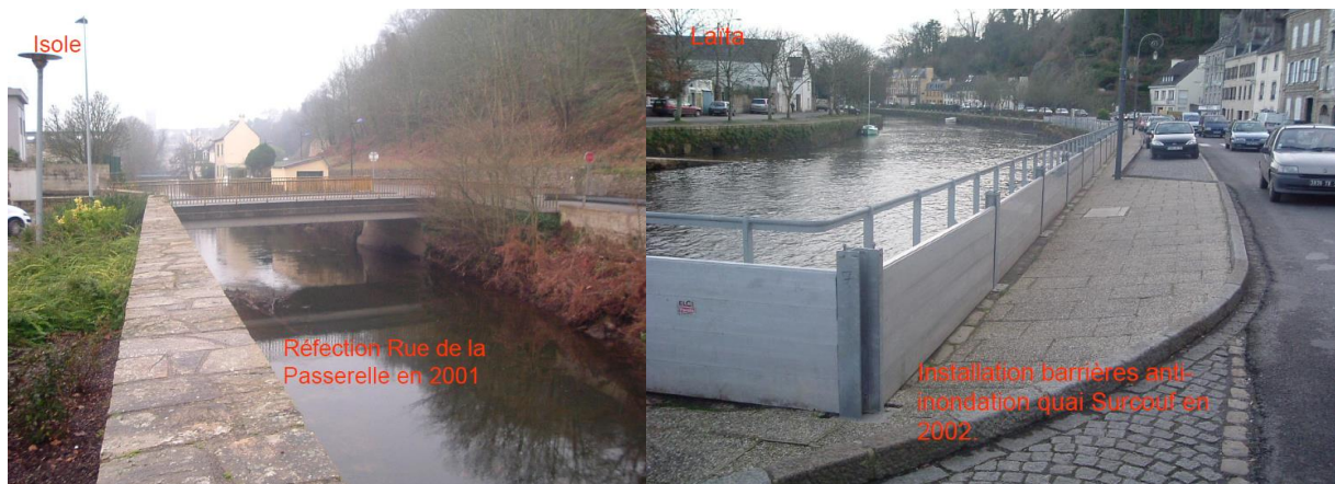
Réfection du pont rue de la Passerelle sur l'Isole en 2001 (Photo 23) et installation des barrières anti-inondations sur le Quai Brizeux (Photo 24) en 2002
