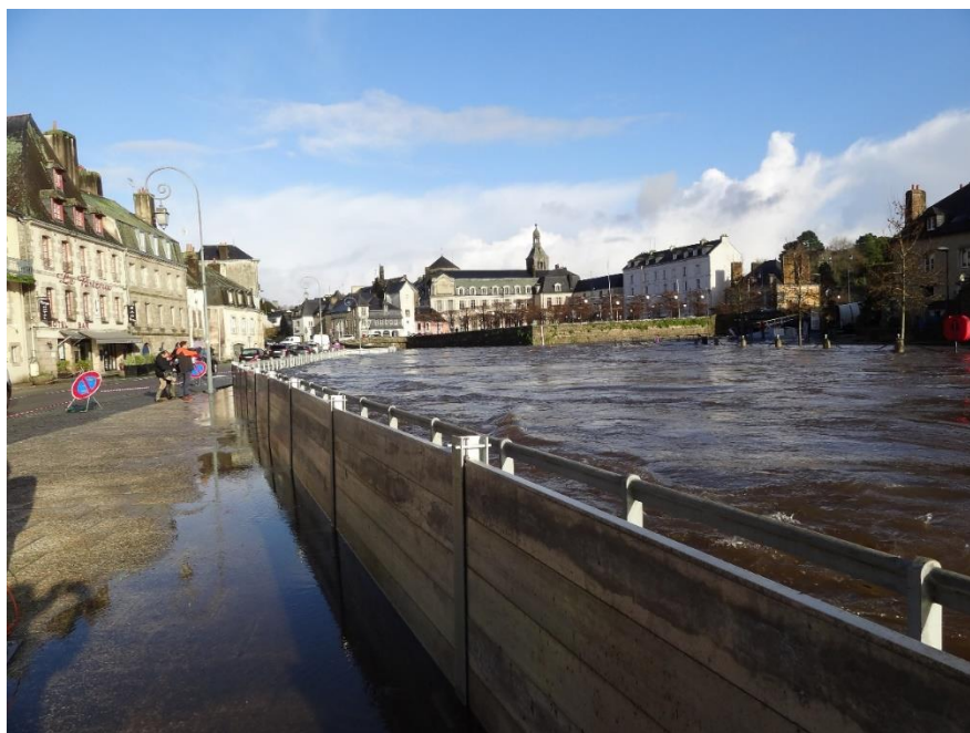
Photo 69 : barrières anti-inondation du Quai Brizeux à Quimperlé lors de la crue de décembre 2019
