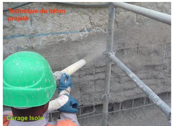
Photo 33: technique de Jet Grouting et Photo 34 : technique du béton projeté sur les fondations
