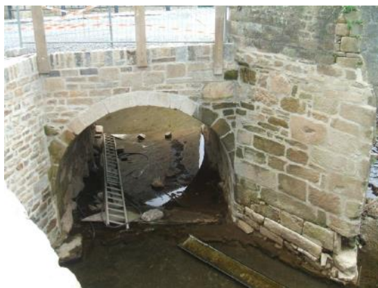
Photo 39 : Ré-ouverture d'une 4 ème arche sur le pont Fleuri sur l'Ellé
