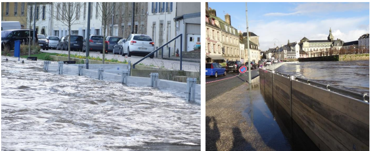
Photo 58 et 59 : Vues vers l'aval puis vers l'amont des barrières du Quai Brizeux lors de la crue de la Laïta du 22/12/2019 à 3,70m
