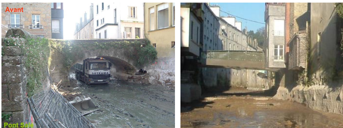
Destruction et reconstruction du pont Isole (Photo 37 : avant, et Photo 38 : après travaux)
