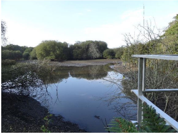
Photo 21 : Ouvrage sur un affluent du Dourdu lié à la zone d'activité Kervidanou 3 (SMEIL,10/10/2014)
